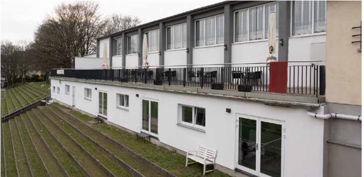
Blick auf die Terasse und den Unterbau mit den Multifunktionsräumen
